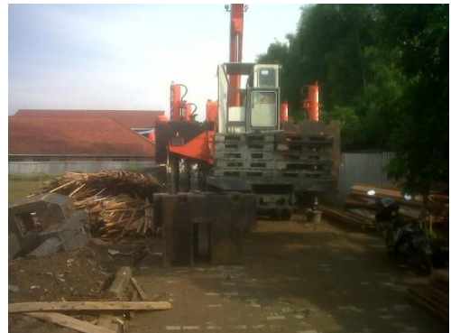
Gambar 4. Kondisi Pembangunan Gedung Baru
